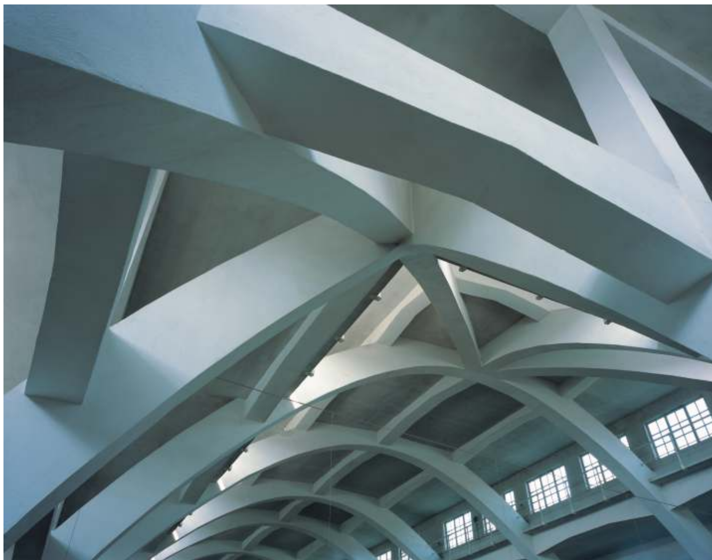
Foto: Pavel Friš, Podolská vodárna
